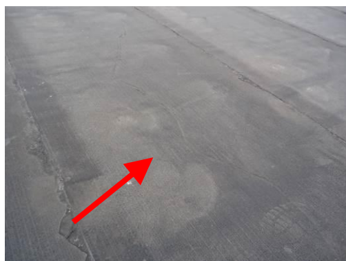
Foto 11: Zuidlaardermeer 10, zichtbare inlage, dak werkplaats
